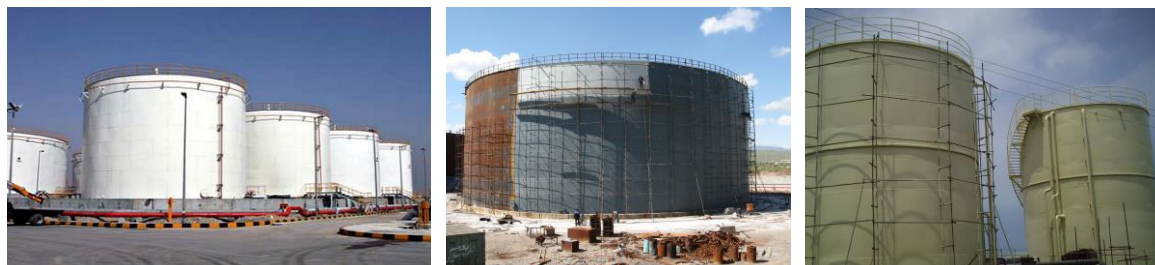
شکل (1) استفاده از مخازن فولادی در نیروگاه ها و پالایشگاه های نفت ۱ و ۲
